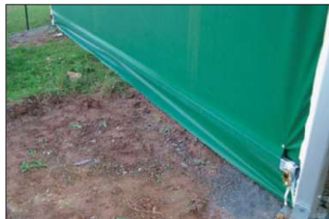
Abspannung der Windschutznetze über fixe Rohre mit Ratschengurten verhindert ein Schlagen der Plane bei Wind
